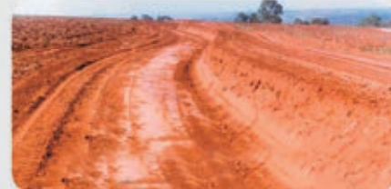
ACABAMENTO EFETUADO COM MOTONIVELADORA
